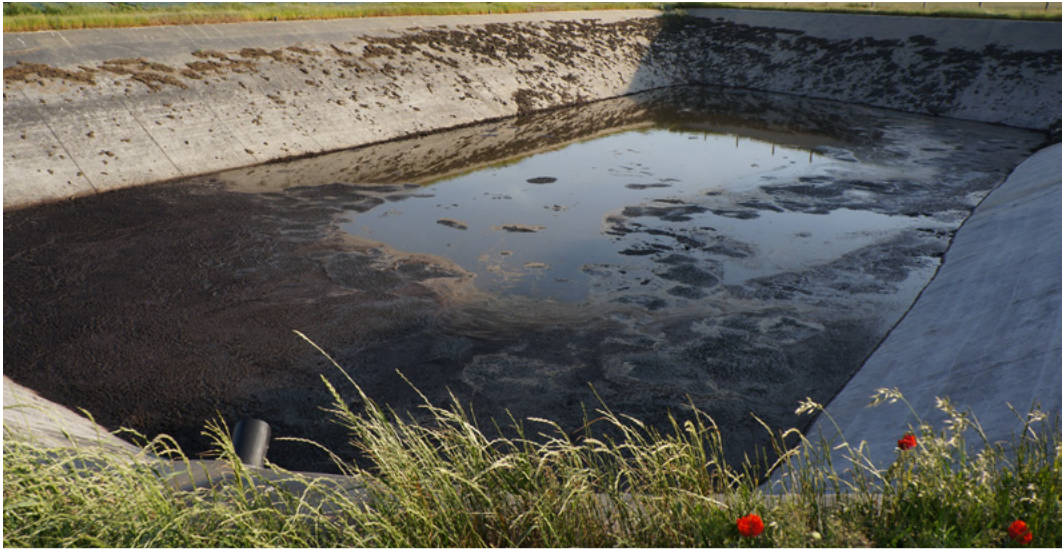
Fosse de stockage de digestat © E. Bro / OFB
