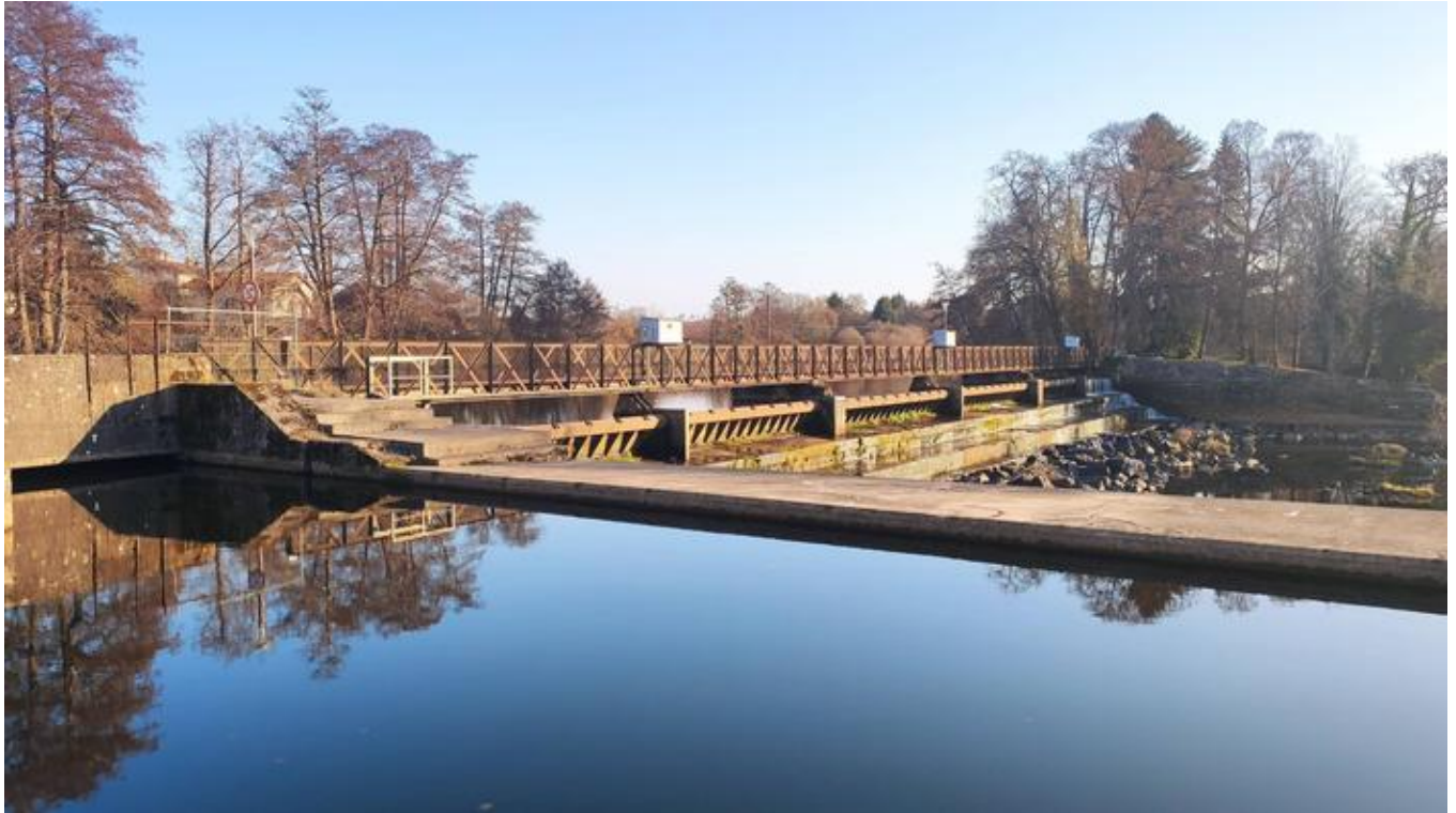
Le barrage hydroélectrique de l'électricien Dream Energy à Baccarat.
