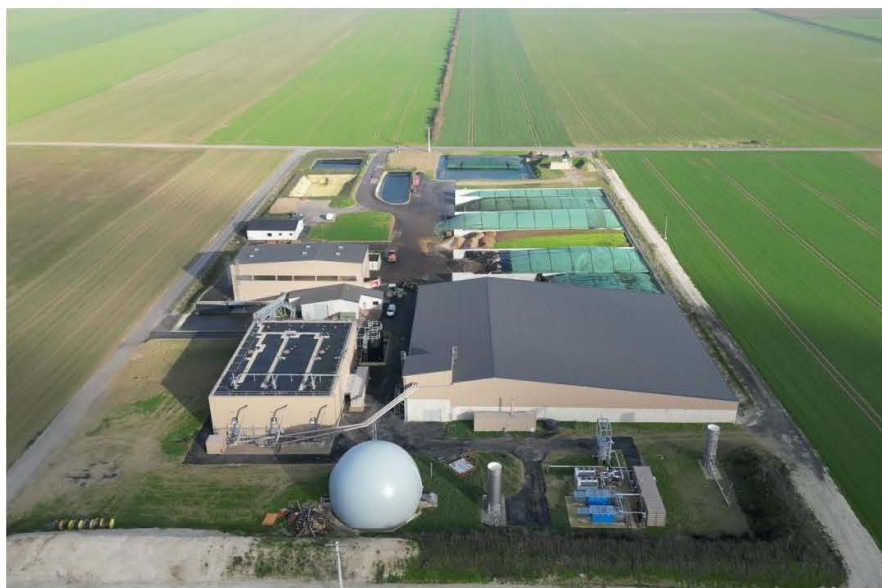
Lancé progressivement depuis août 2022, le site Méthabaz, au nord de Reims, doit revoir sa sécurité incendie avant de produire à une échelle industrielle. D. R.
