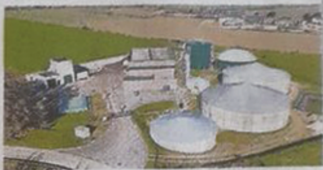
L'usine de méthanisation Biogaz Kastellin, à Châteaulin (Finistère).
