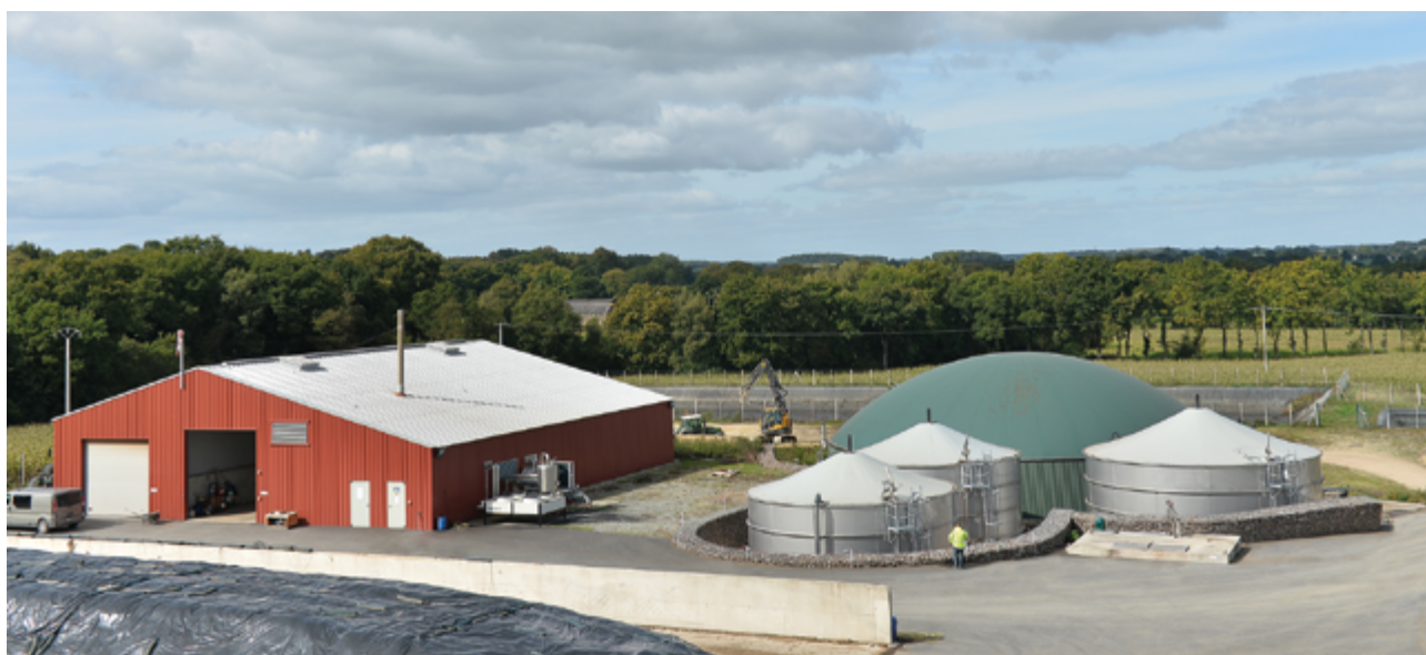
Vue aérienne d'une installation de méthanisation agricole.
