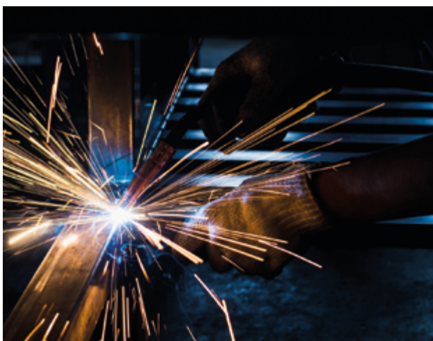
Opération de travail par point chaud
