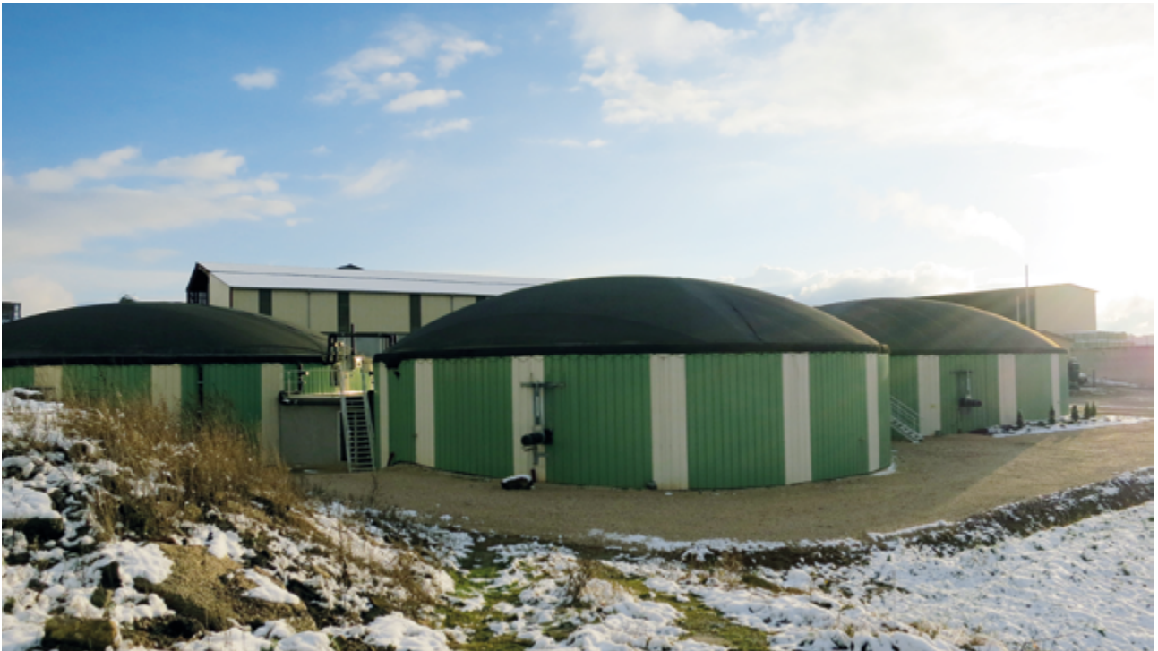
Vue de la partie digestion d'une unité de méthanisation
