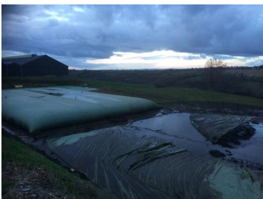
Perçement d'une citerne souple de digestat (source : SDIS)
