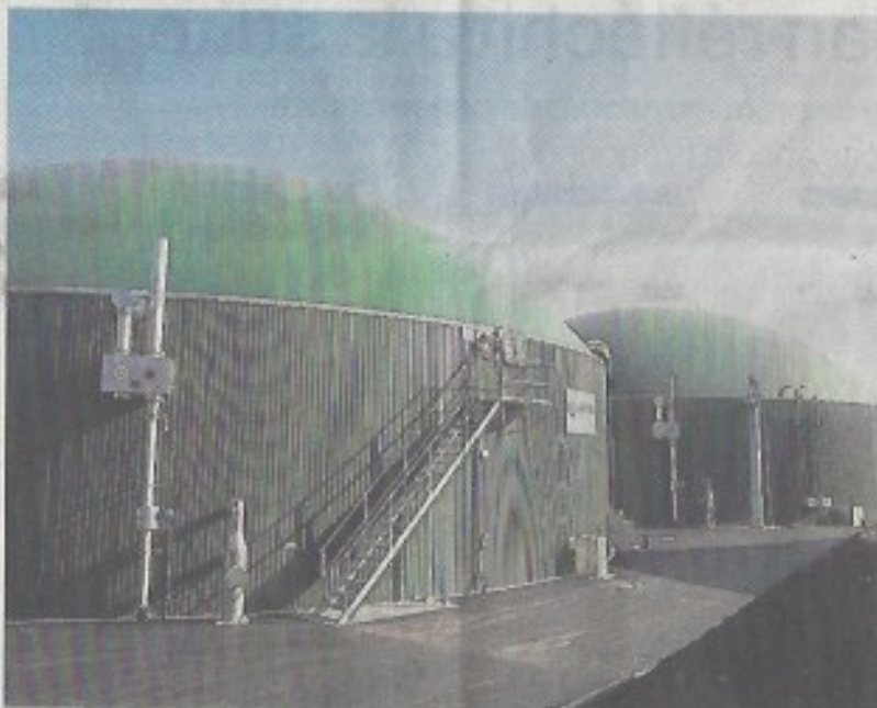
Exemple d'une unité de méthanisation.
