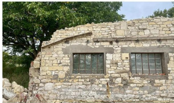
Gournay-sur-Aronde (Oise), vendredi. Avec la mise en place du plan de prévention des risques technologiques (PPRT), dix familles du hameau de Saint-Maur ont été expropriées et leurs maisons, détruites.
